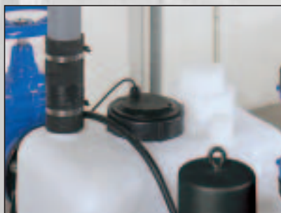
Ellenőrző fedél beépített szintérzékelővel
